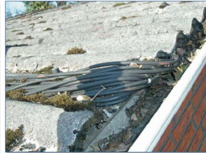
Bild 9 | Nicht fachgerechte Kabelführung: Befestigung, Kantenschutz fehlt.
