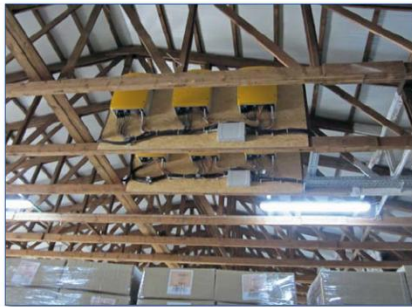
Bild 6 | Installation der Wechselrichter über brennbarem Lagergut.
