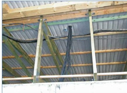
Bild 8 | Nicht fachgerechte Kabelführung.
