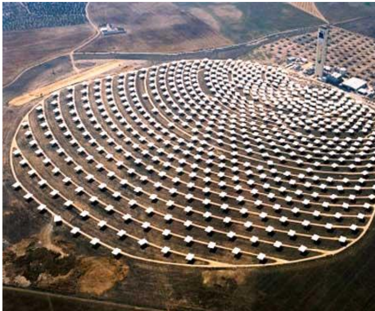
Solartherm. Kraftwerk bei Sevilla, Quelle: SDZ
